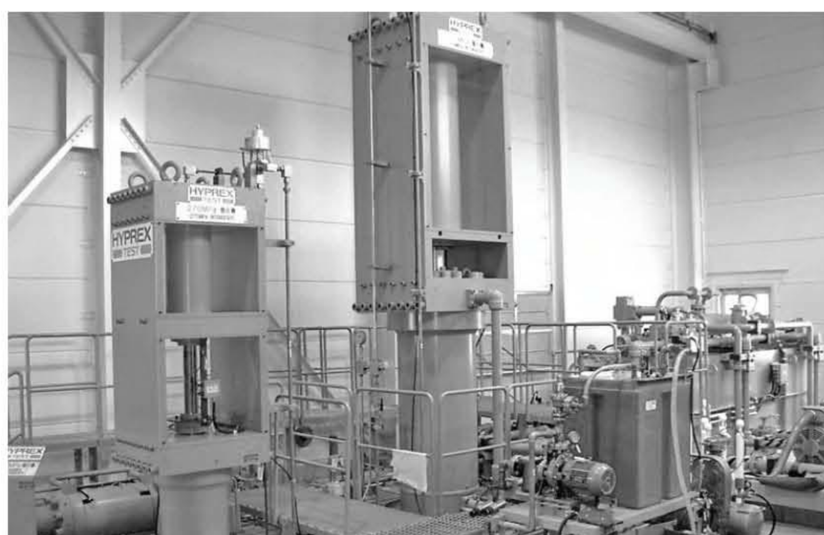
写真3 加圧試験装置の全景
